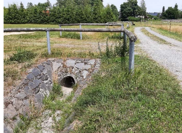
Abb. 9: offener Floßgraben mit Zufahrtbereich zur nordwestlichen Teilfläche
